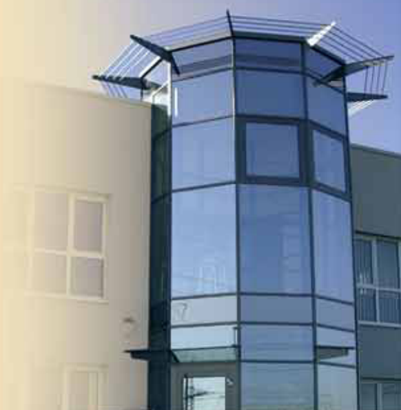
Штаб-квартира MS Westfalia GmbH Тройсдорф (Германия)
