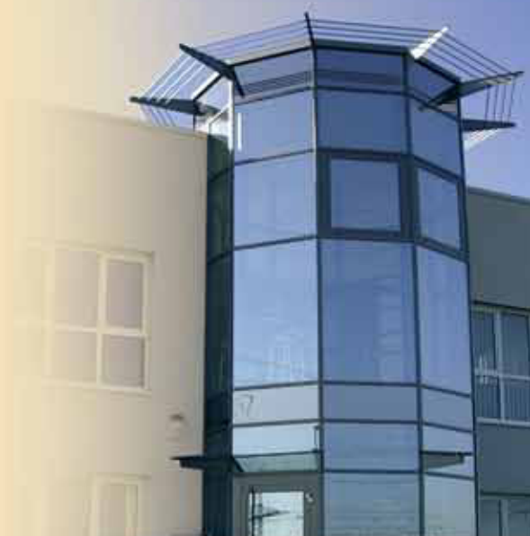
Штаб-квартира MS Westfalia GmbH Тройсдорф (Германия)
