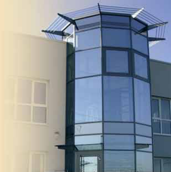
Штаб-квартира MS Westfalia GmbH Тройсдорф (Германия)
